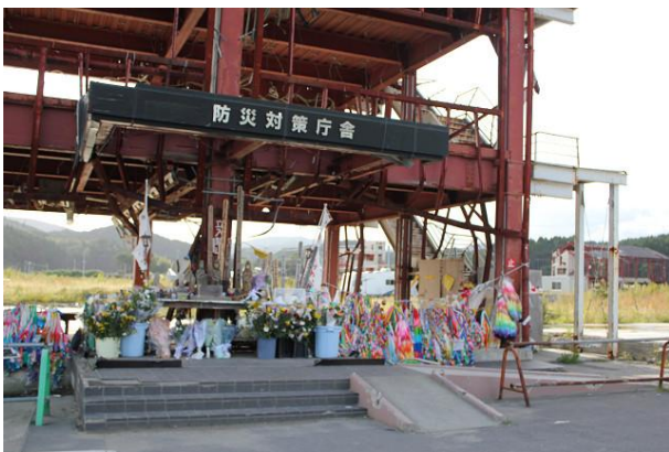
志津川にある南三陸町の防災対策庁舎
