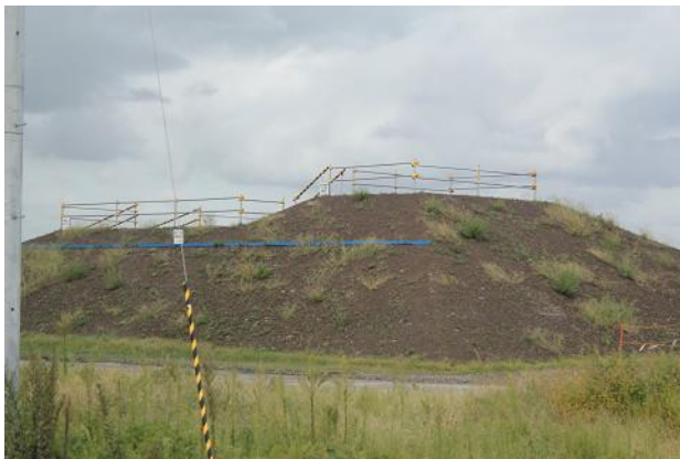
計画の嵩上げを分かり易くするために、部分的に盛土がされていた。
