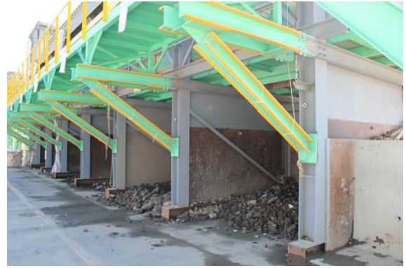
選別された瓦礫は、塩ビ、廃プラ、金属類などに分別され、ここに落とされる。
