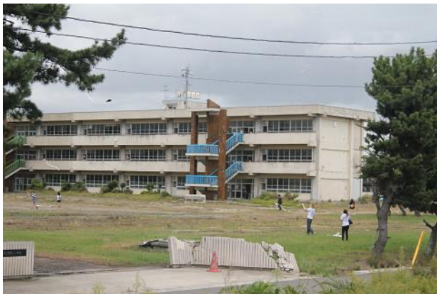
津波から多くの人を救った閉上中学校の校舎
