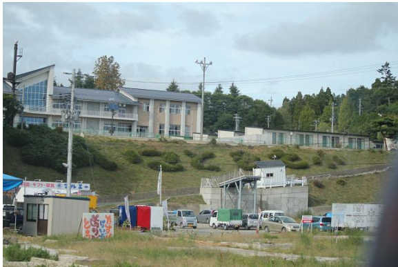
高台にある歌津中学校は津波から逃れたが、下にあった民家は津波にさらわれた。
