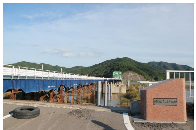
ヒロセ(株)のプレガーダー橋で仮復旧された北上大橋
