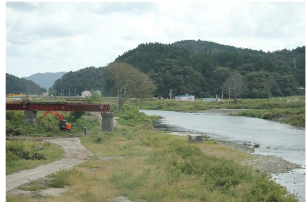
津波で流失した大船渡線の鉄道橋
