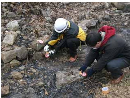
ターゲットマーカーを設置
