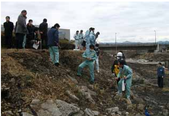
南国オフィスパークの隣の国分川の堤防で、 3班に分かれて横断測量位置を決める。
