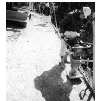
壁背面付近転圧状況
