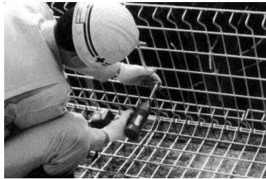
壁面材組立て状況
