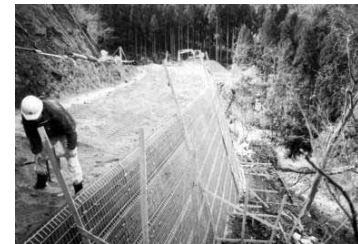
盛土材敷き均し状況
