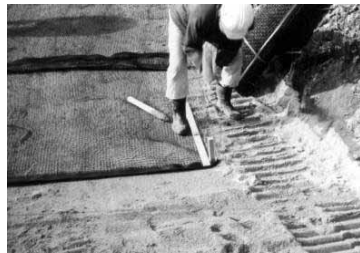
ジオグリッド取付け状況
