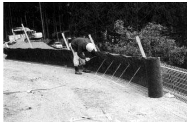
植生マット設置状況
