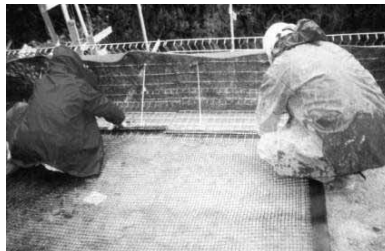
仮止め杭施工状況
