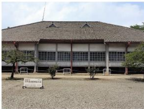
ブリュナ館。製紙所の建設を指導したフランス人ブリュナが家族と一緒に住んでいた建物で、916.8m 2 (278坪)もの広さがあった。
