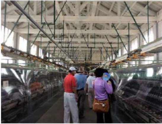
小屋組は木造のキングポストトラス。
