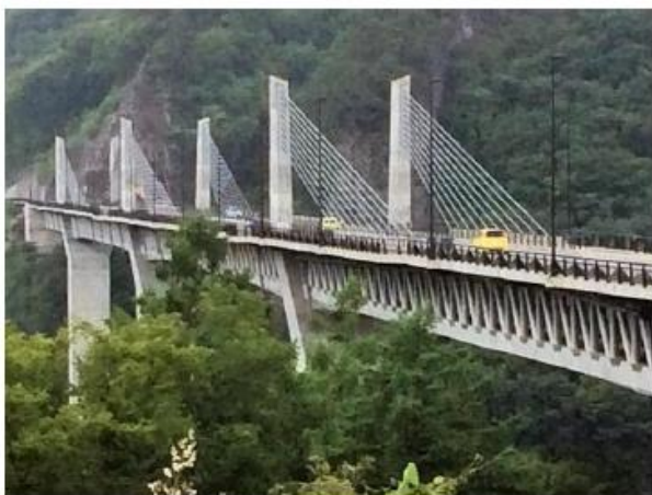
道の駅八ッ場ふるさと館の側に架かっている不動大橋。「PC 複合トラス」と「エクストラードロード橋」の技術を融合した世界初の鋼・コンクリート複合トラス・エクストラードロード橋。橋長 590m。支間 63.4m+125m+2@155m+88.4m 。
