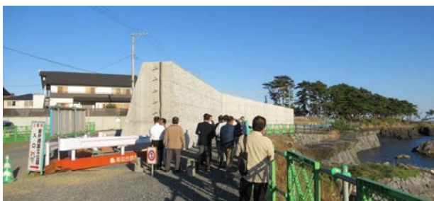
気仙沼市岩井崎海岸の復旧状況
