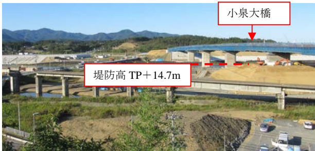
気仙沼市津谷川河口部の復旧状況
