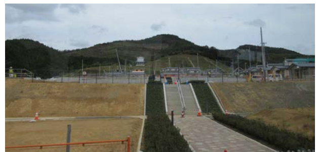
高台に造成が進む住宅団地(宮ヶ崎地区)
